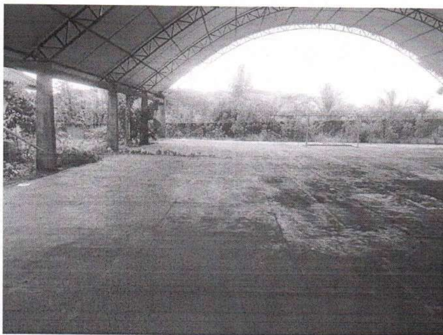
FOTO 01: QUADRA A SER REFORMADA
