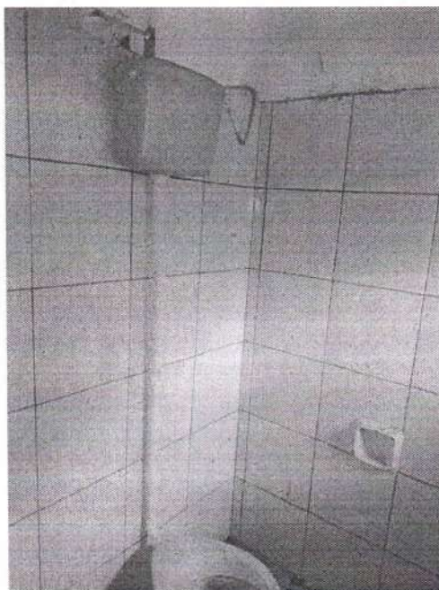
FOTO 06: REFORMA DO BANHEIRO, SUBSTITUIÇÃO DE LOUÇA, REVESTIMENTOS, PINTURA E FORRO.
