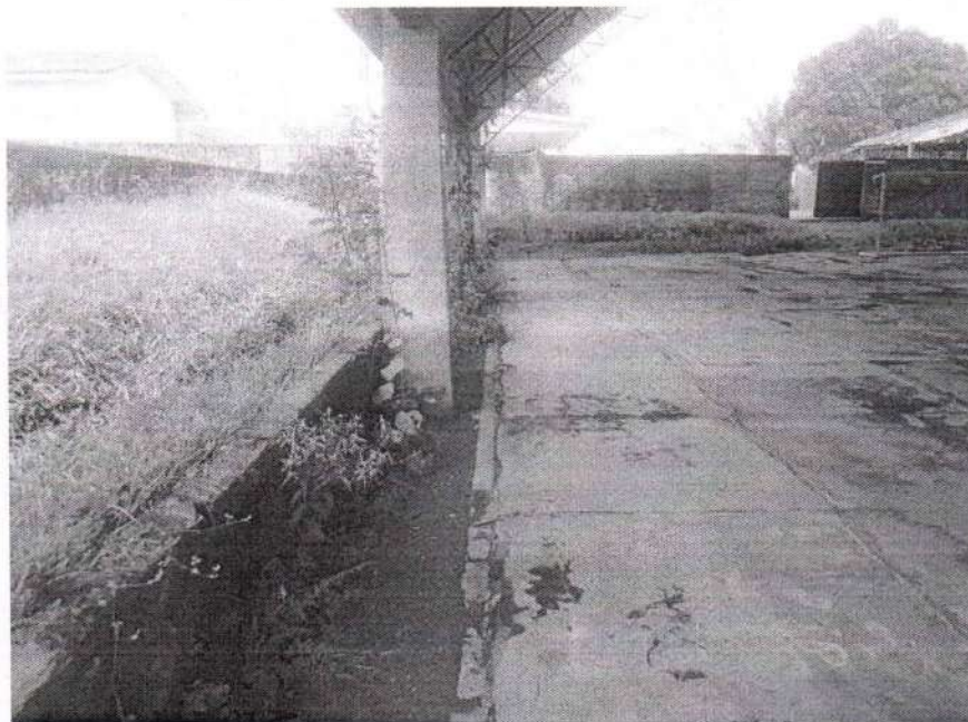
FOTO 05: LATERAL DA QUADRA, EXECUÇÃO DO DRENO.
